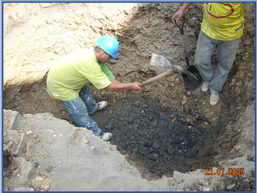
Figura 3 Extracción de la tierra contaminada
