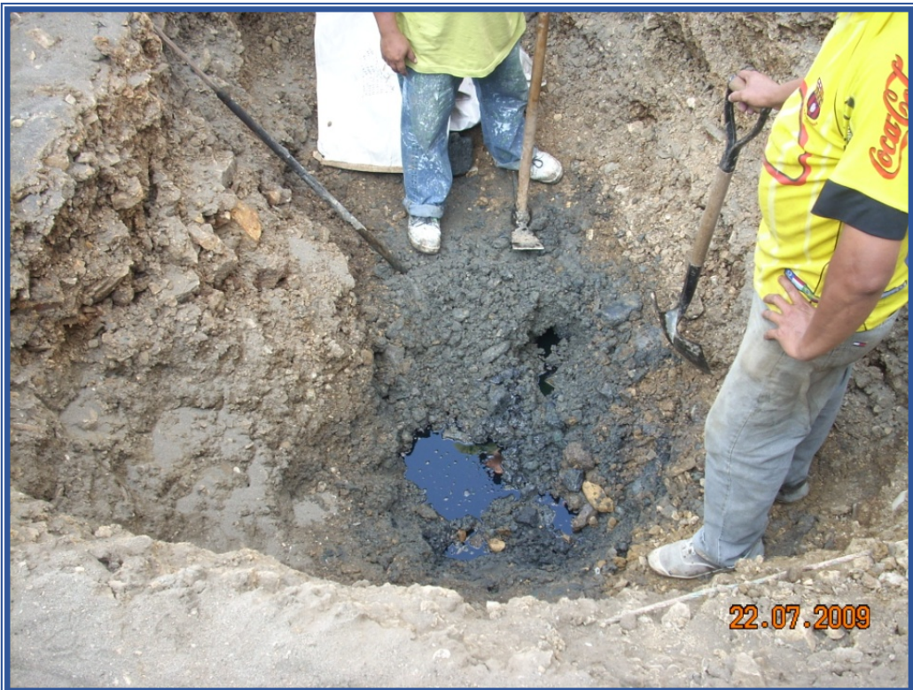
Figura 4 Extracción de la tierra contaminada
