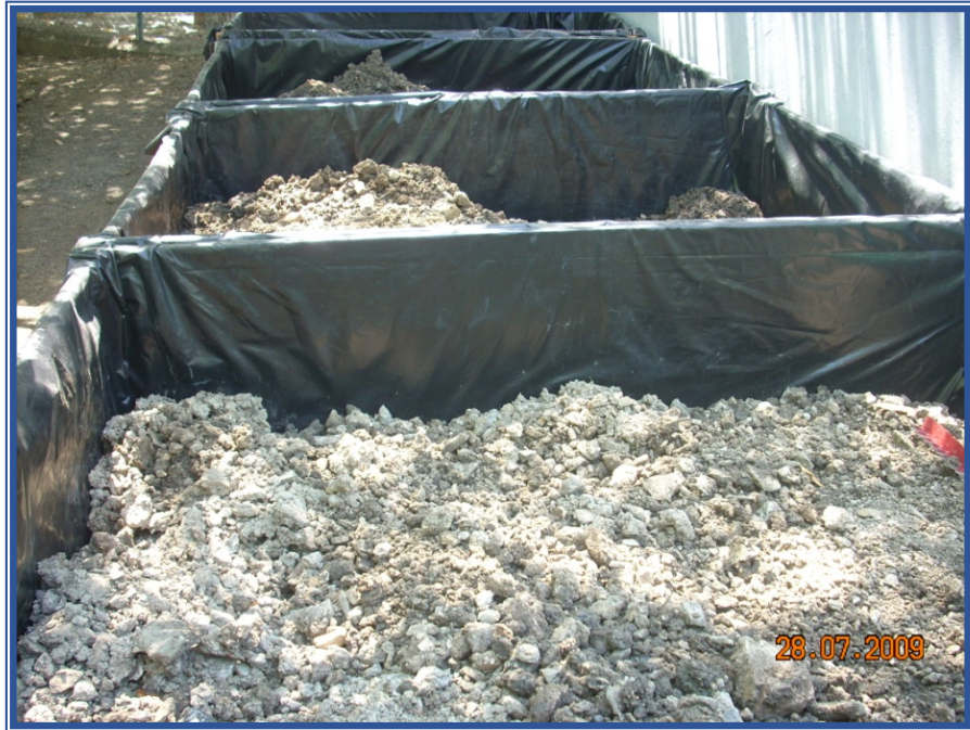
Figura 10 Ubicación de la tierra contaminada en las microceldas de landfarming
