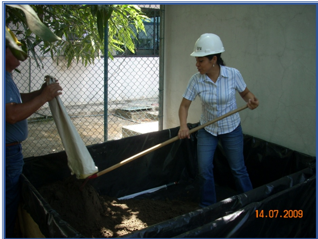
Figura 6 Colocación de la capa de arena y/o filtro de arena para lixiviados
